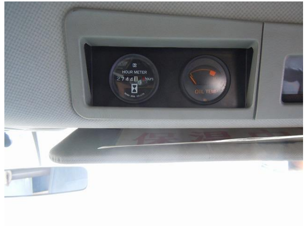
アワーメーター状況(R2.1.27 現在)
